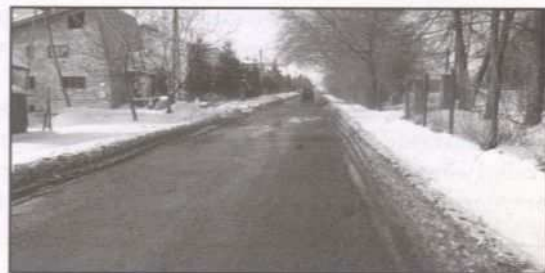
Na modernizację ul. Spacerowej w Zbylitowskiej Górze w budżecie zapisano 850 tys. zł
