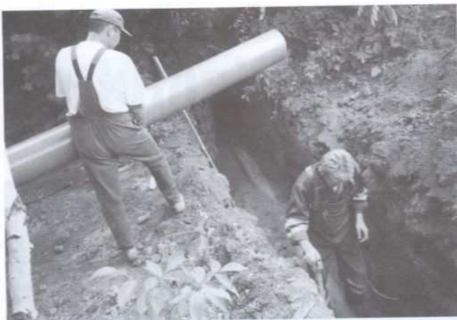
Prace przy budowie kanalizacji w Koszycach Małych, współfinansowane przez unijny fundusz SAPARD, przebiegają bardzo sprawnie. Fot. (am)
