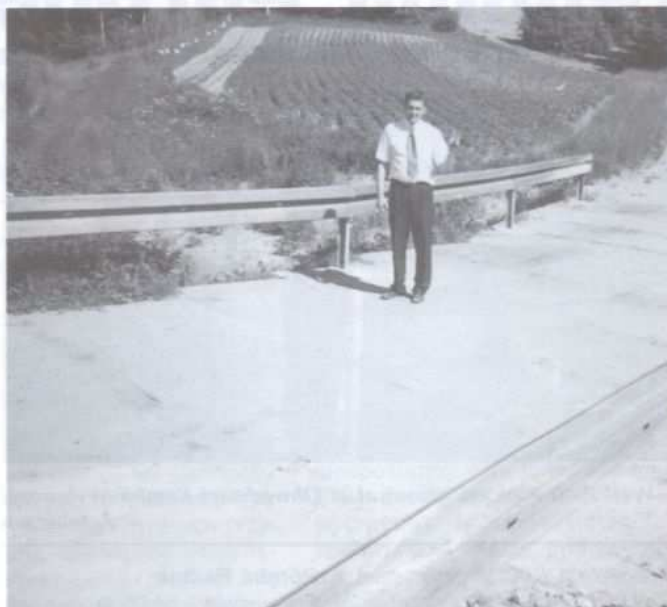
Wójt Piotr Molczyk osobiście sprawdzał jak przebiegają prace nad remontem mostu w Zawadzie
