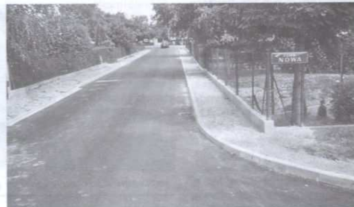
Nawierzchnię asfaltową zyskała m.in. ul. Nowa w Zgłobicach
