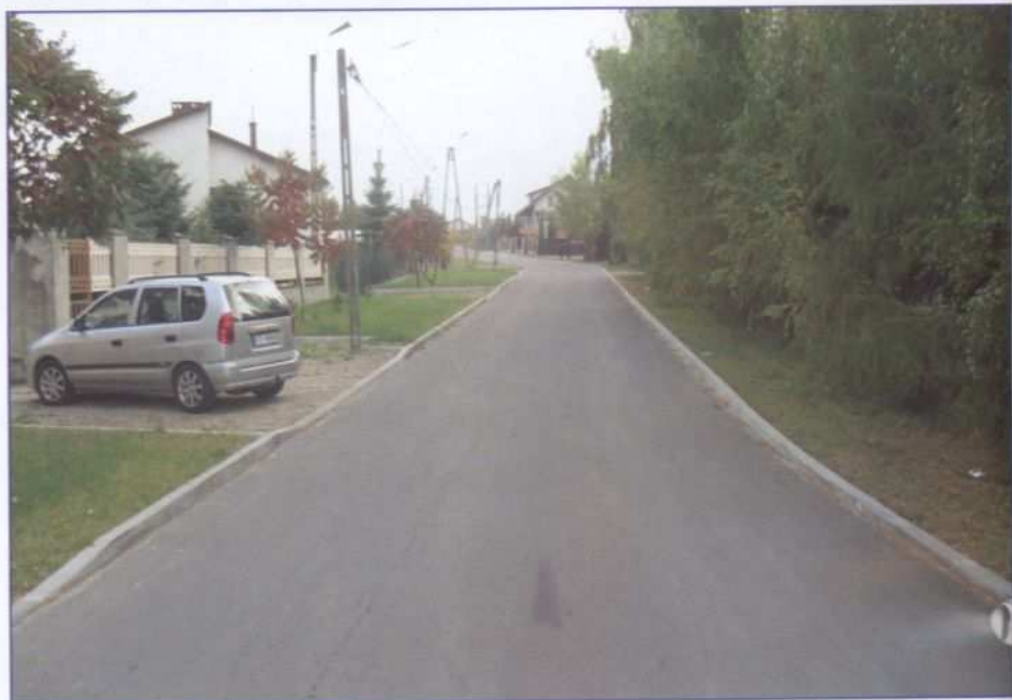
Ul. Długa po przebudowie
