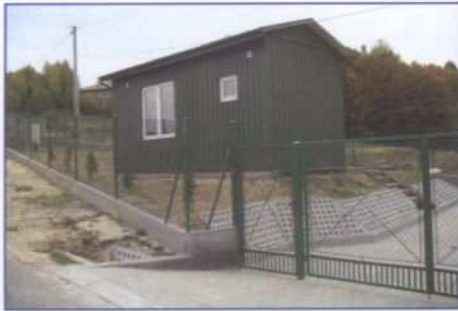
Pompownia wody w Łękawce
