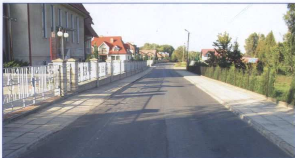
Wyremontowana droga koło Kościoła
