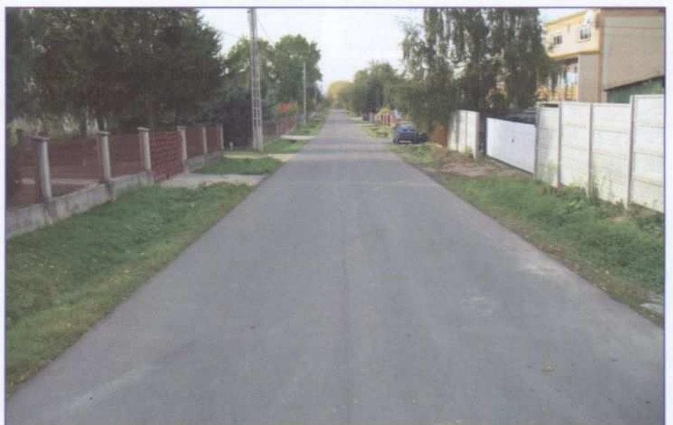
Wyasfaltowana droga do Domu Pomocy Społecznej
