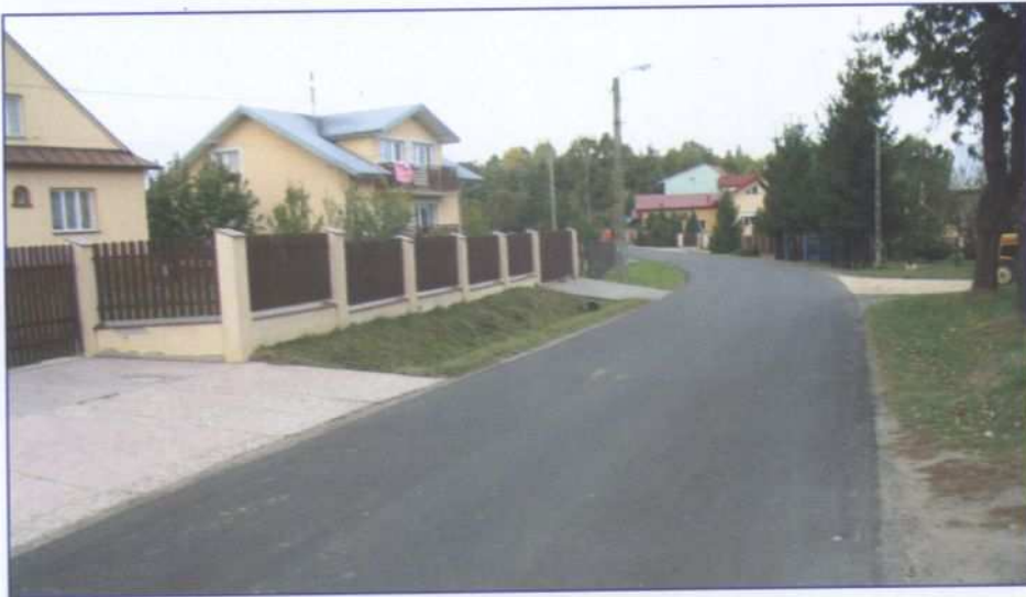
Zmodernizowana została droga od pętli autobusowej do Kościoła
