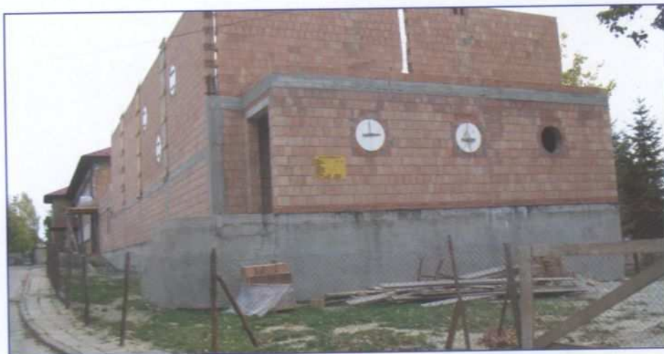
Budowana sala gimnastyczna
