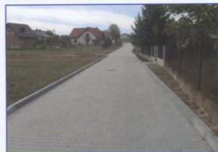
Droga „Leśnica” w całości wyłożona została kostką betonową
