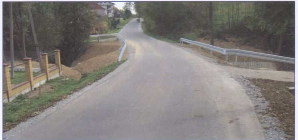
Droga koło szkoły z wyremontowanym mostem
