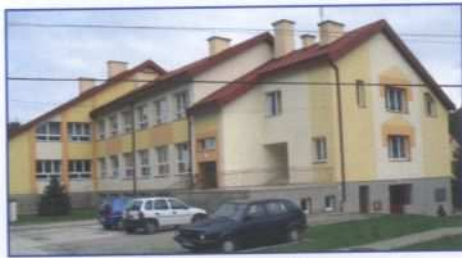
Budynek Szkoły Podstawowej z nowym dachem, oknami i elewacją
