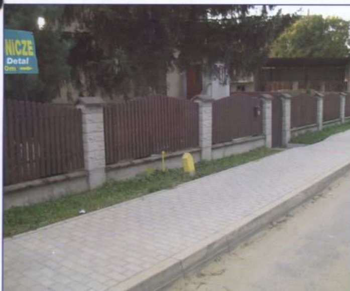
Chodnik przy ul. Wesołej
