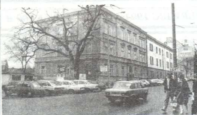
Remontowany budynek Urzędu Gminy
