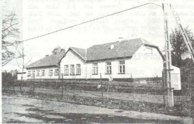
Wyremontowana szkoła w Jodłówce Walki - efekt pracy samorządu
