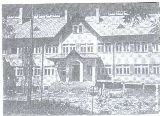
Na wykończenie szkoły potrzeba ponad 150 tysięcy
