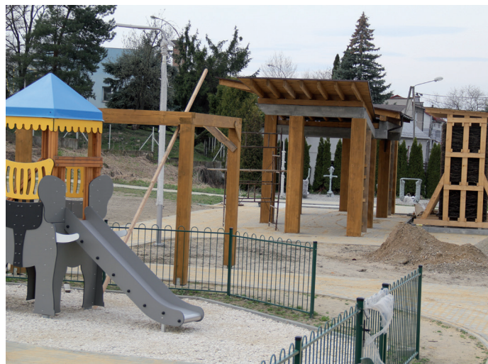
Budowa Centrum Wsi w Tarnowcu z tężnią solankową
