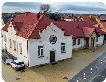
Remont Parafialnego Domu Kultury w Woli Rzędzińskiej I
