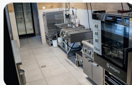
Doposażenie kuchni i remont remizy OSP w Jodłowce-Wałkach
