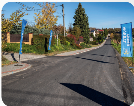
Remont drogi gminnej w Zawadzie
