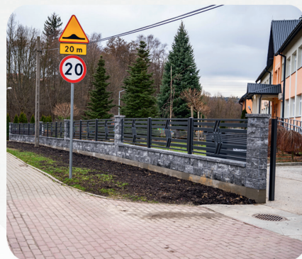
Ogrodzenie szkoły w Łękawce
