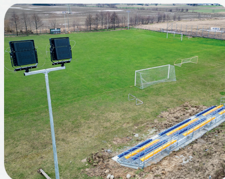
Budowa trybun i oświetlenia na boisku KS Radlna
