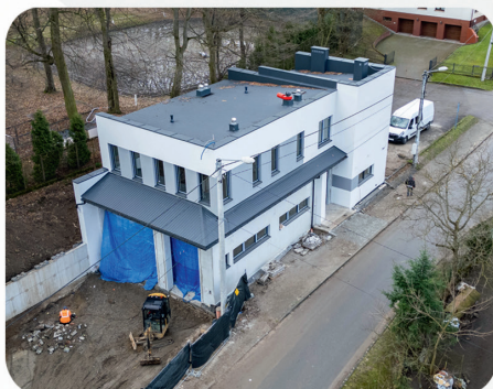
Budowa remizy OSP w Zbylitowskiej Górze
