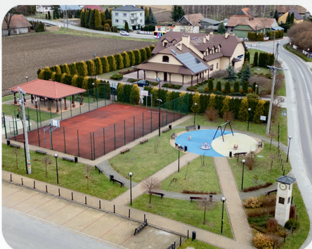
Montaż instalacji fotowoltaicznej na dachu Domu Kultury w Radnej
