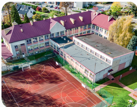
Remont budynku szkoły i budowa boiska w Zbylitowskiej Górze
