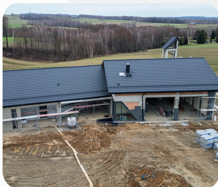
Budowa Domu Kultury z remizą OSP w Łękawce
