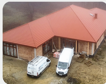
Budowa Domu Kultury w Zawadzie
